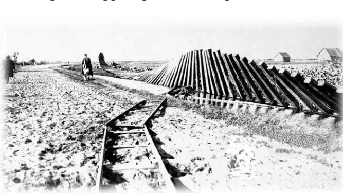
Размытые и отнесенные в сторону железнодорожные пути. п. Лахта. 1924 год
