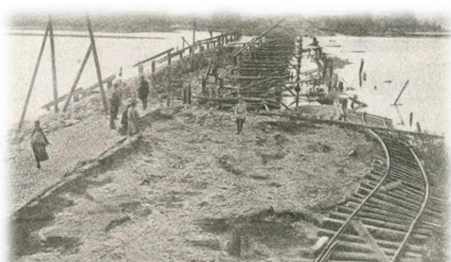
Размытые и отнесенные в сторону железнодорожные пути. п. Лахта. 1924 год
